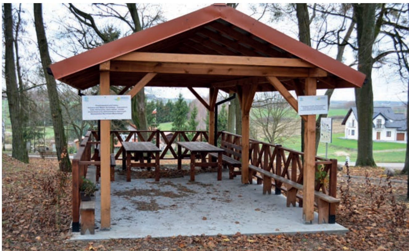
Budowa i doposażenie wiaty w Mątykach - gmina Iława.
