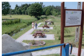
Zagospodarowanie brzegu rzeki Płończanki (sołectwo Turza Mała, gmina Płońnica)
